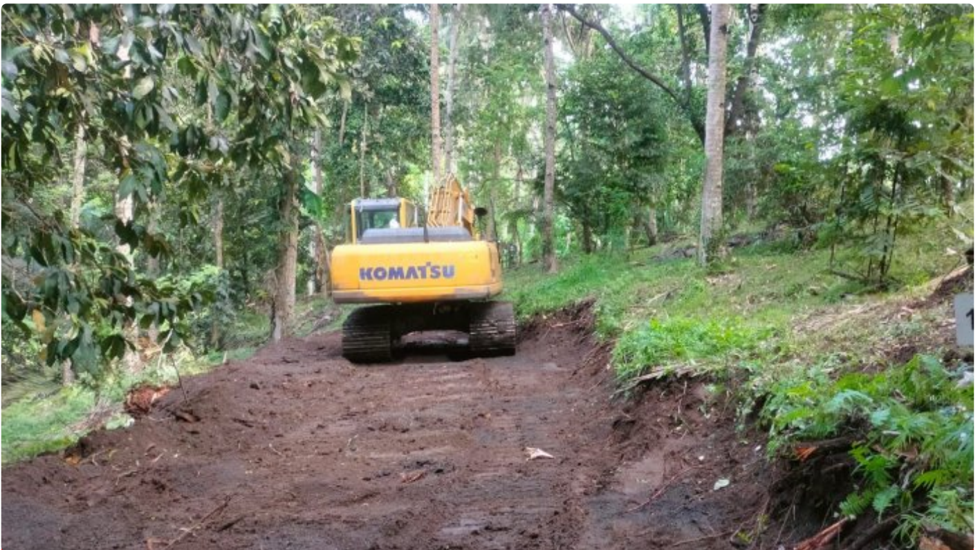
Pekerjaan Perintisan Jalan Pertanian pada TMMMD Ke-116 Kodim 1310 Bitung di Tandurusa
