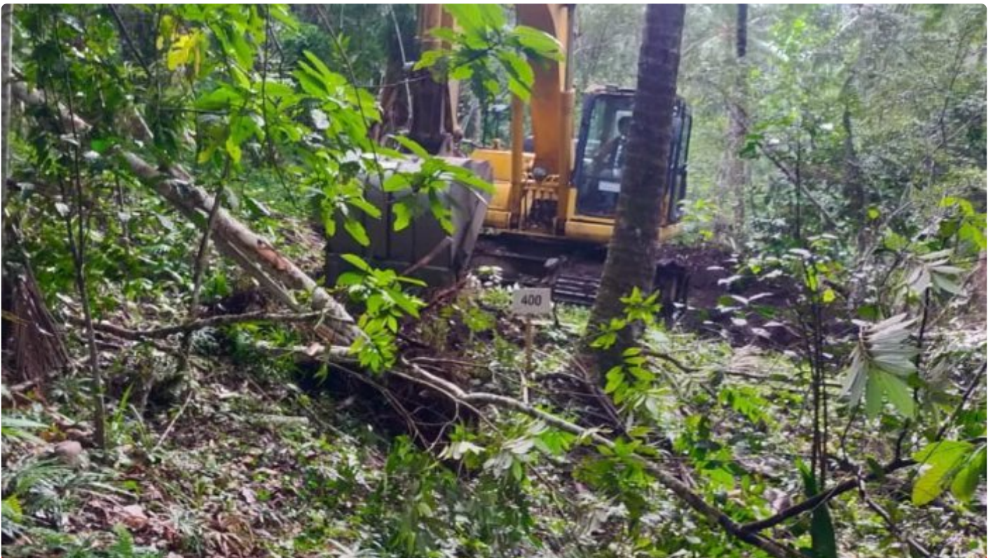
Pekerjaan akses Jalan TMMD Ke-116
