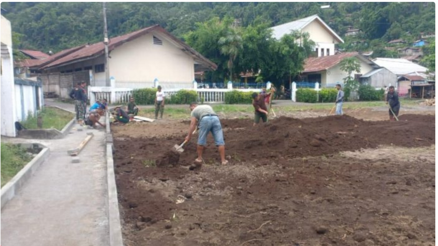
Sarana olah Raga Jogging Track TMMD Ke-116 Kodim 1310 Bitung di Kelurahan Tandurusa
